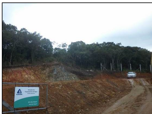
Imagem 3: Aquisição e preparo do terreno para implantação da ETA
