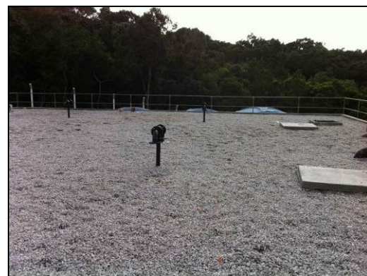
Imagem 6: Laje superior reservatório
