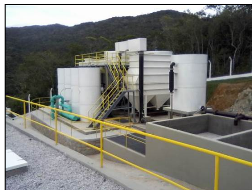
Imagem 4: Implantação da ETA pré-fabricada.
